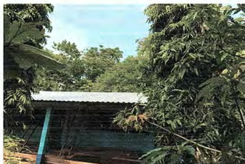
Foto 5: Cambio de lámina existente por lámina troquelada calibre 26 en módulo 1.
