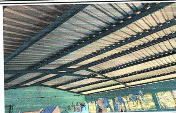
Foto 2: Aula 2 del módulo 2. Mantenimiento a estructura de techo y aplicación de anticorrosivo.
