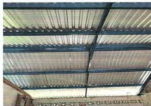
Foto 4: Se realizó sustitución de techo de madera por estructura de metal en las aulas del módulo 1.
