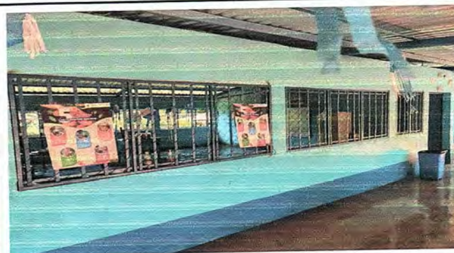
Foto 4: Se restauraron los balcones de las dos aulas del módulo 2 ya que estos son de malla, se pintarán y se reforzaron con llantillas.
